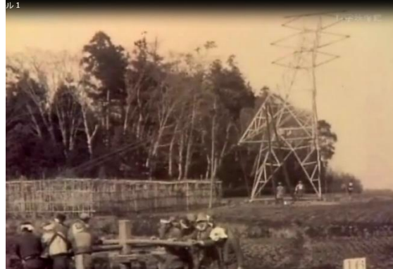
送電塔は地上で組み立てから、人力で引き上げた
