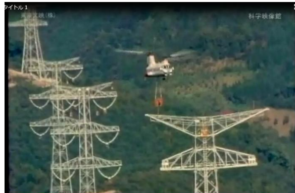
日本の送電技術は世界トップクラス。現在、50万ボルトの超高圧送電網(もう)が作られている
