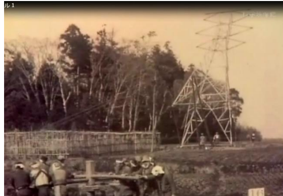
送電塔は地上で組み立てから、人力で引き上げた
