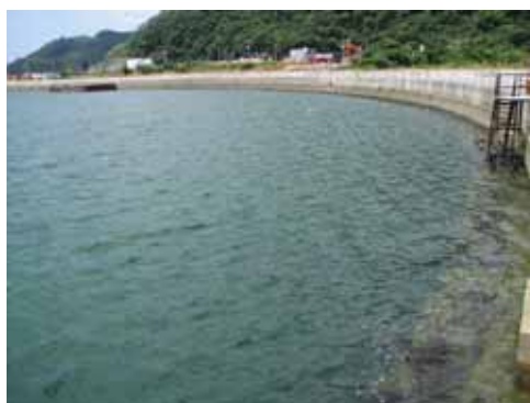
図 3-2 実証試験実施場所全景(B-2 護岸より B-1 護岸を望む)
