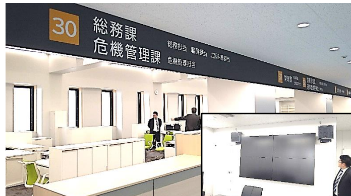
災害対策本部会議室の大型モニターから、港など災害現場の状況を監視することが出来る。
