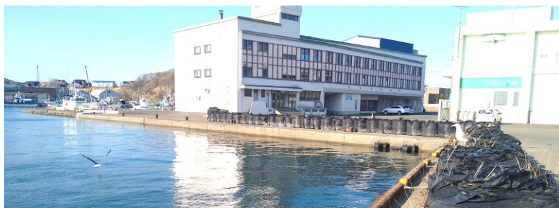
今回、計画に追加された根室港区中央地区整備。奥に見える根室漁業付近の海岸町物揚場について、浸水対策のため11mの前出しと天端高の50cm高上げを行う。また増深することで中央地区全体の水深を4.0メートルに統一し利便性の向上を図る。
