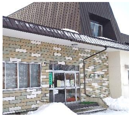
解体される予定の花咲港会館
