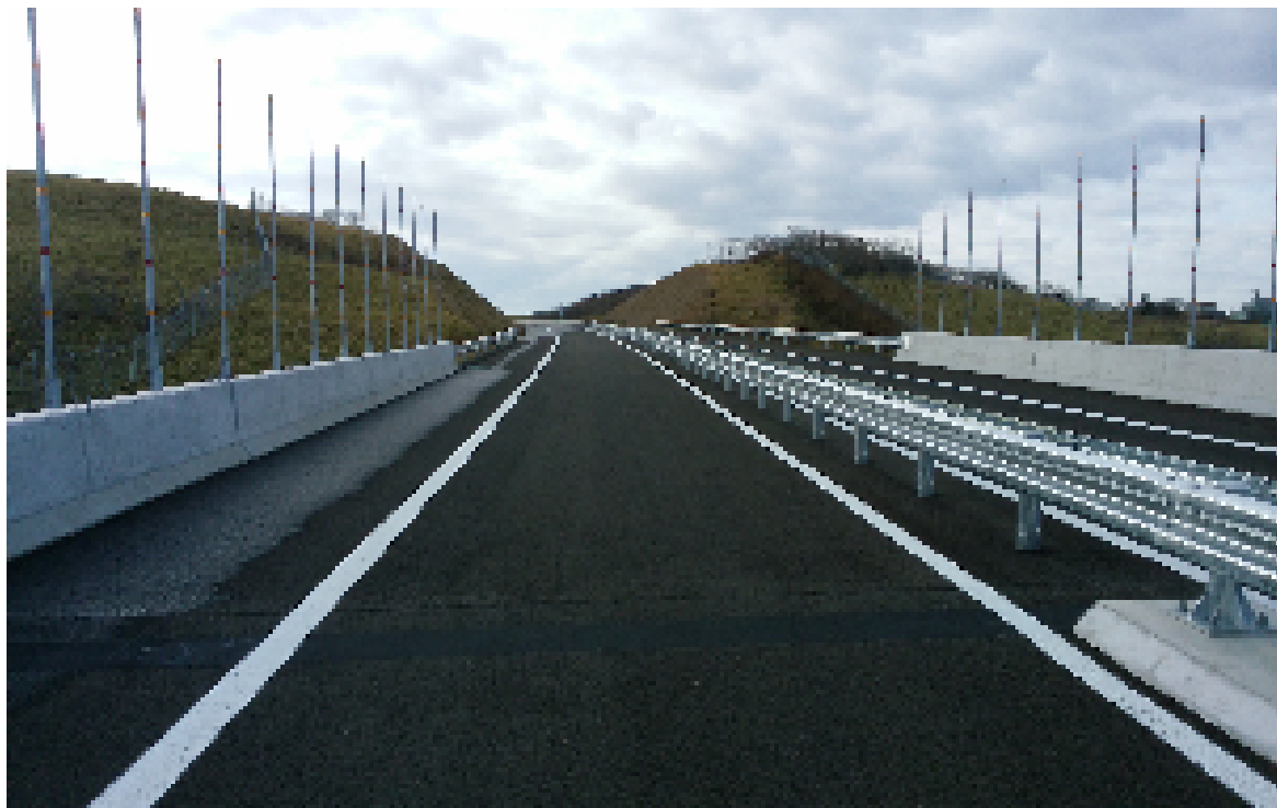
根室道路の中間付近、幌茂尻川橋より温根沼IC方面をのぞむ
