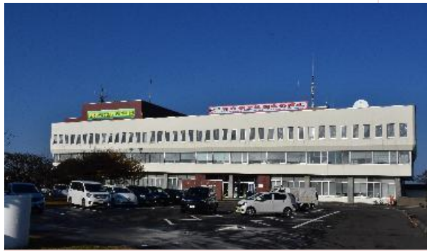
根室市役所。2009年の耐震診断では「震度6強程度の地震により倒壊または崩壊する危険性がある」とされている。昨年の市民アンケート結果では「建替え」の回答が67.2%を占めた。
