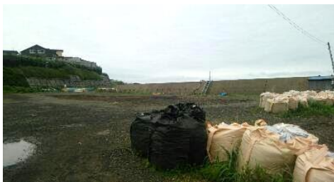
高潮被害で取り壊された後、新たに建設される根室漁協の栽培漁業センターの予定地(弥生町)
