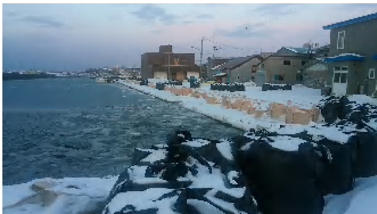
スーパー土嚢が並んでいる、現在の弥生町“船溜まり場”の様子
