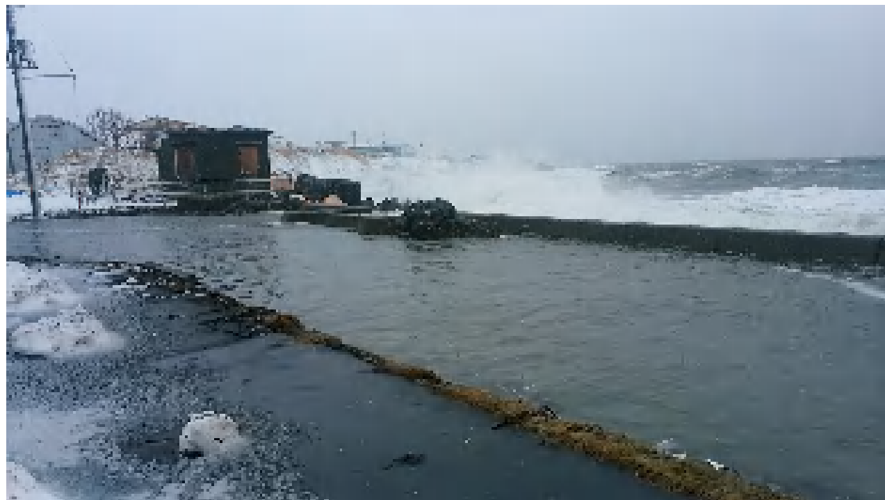
20日午前9時半ころ、西浜町「根室国後間海底ケーブル陸揚げ施設」付近の様子
